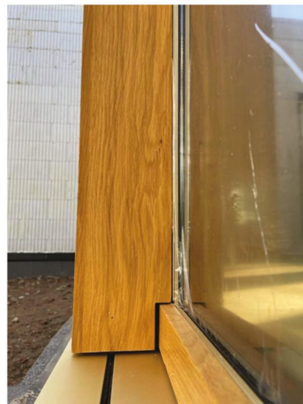
La pose des menuiseries a été faite en applique extérieure avec un seuil invisible à système de récupération des eaux et caniveau au niveau du sol.
