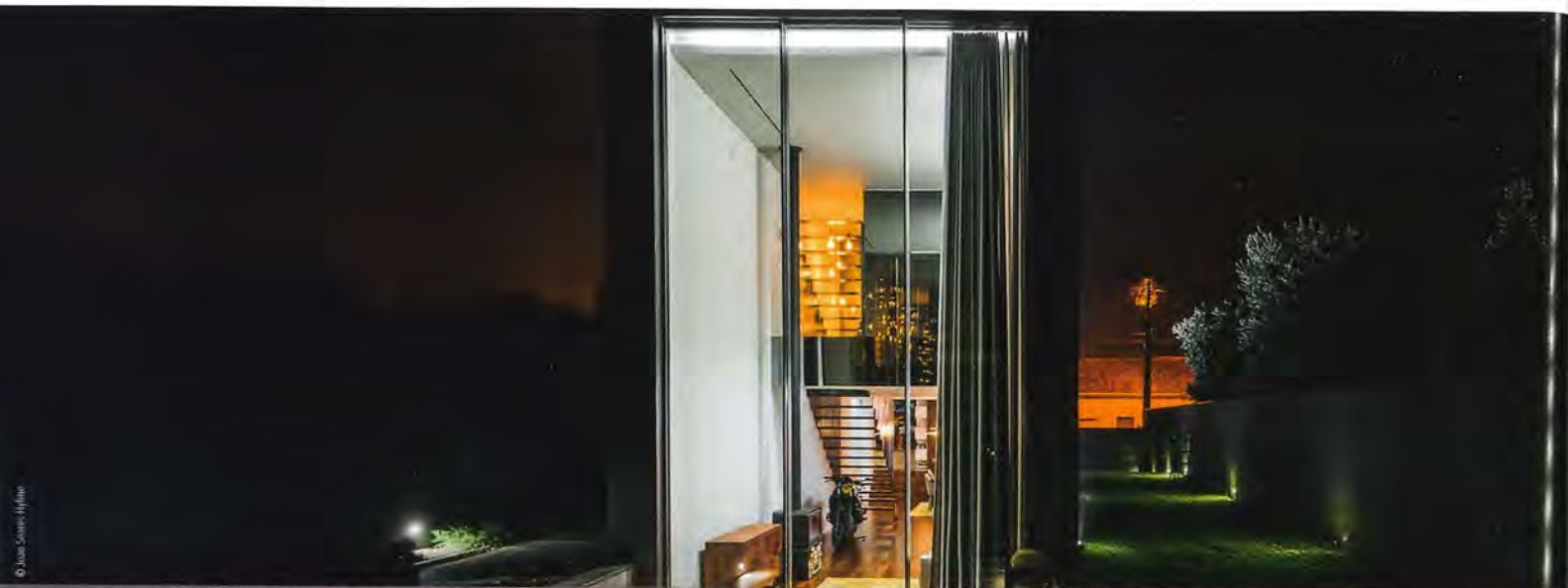
Construite au Portugal, à Vila do Conde, la Cork House est une résidence contemporaine due au coup de crayon de AIP Arquitetos. Les matériaux utilisés à l'intérieur et à l'extérieur, la conception dimensionnelle et la taille singulière du coulissant XXL Hyline 40, rendent cet ouvrage unique - Villa Cork - Architectes : AIP Arquitetos - Produit : Hyline 40
